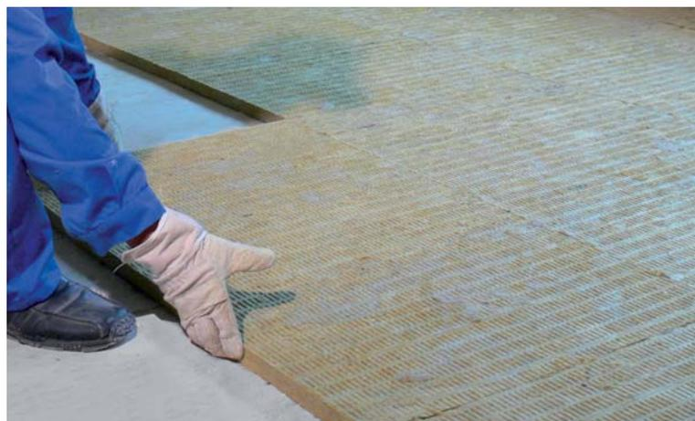
Im Thermal- und Therapiebereich wurde zur Trittschalldämmung die hochverdichtete Steinwolleplatte Heralan TPT eingesetzt.
